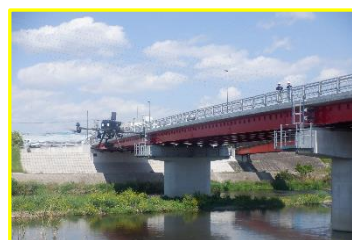
ドローンを活用した点検のようす
