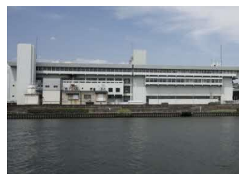
庄内下水処理場
