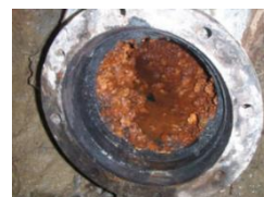
古くなった水道管の内部
