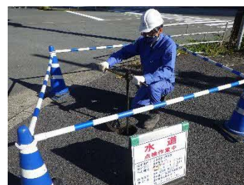
水道施設の点検のようす
