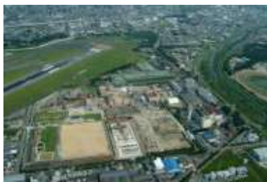
原田処理場の全景
