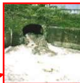
雨天時の未処理下水放流状況
