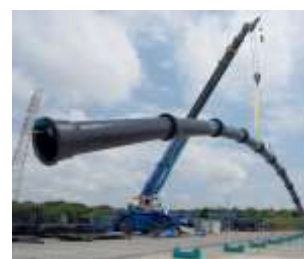
耐震管※のデモンストレーション
