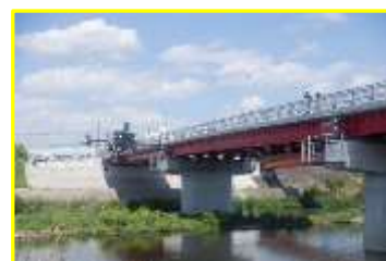
ドローンを活用した点検のようす
