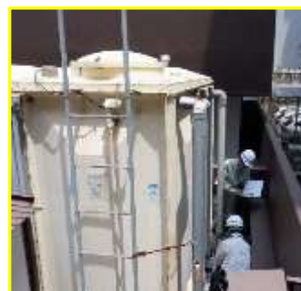
受水槽の管理状況調査のようす
