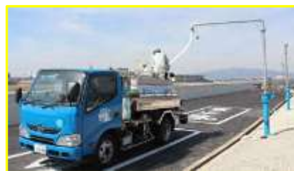
給水タンク車用給水設備
