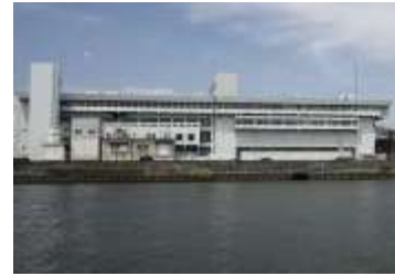
庄内下水処理場
