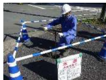
水道施設の点検のようす
