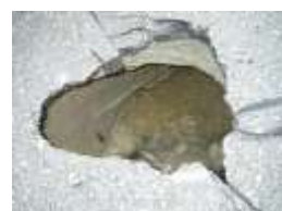
管路施設の老朽化が原因と考えられる道路の陥没
