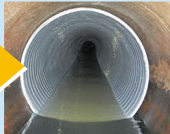
古い管の中に新しい管を通して修繕します
