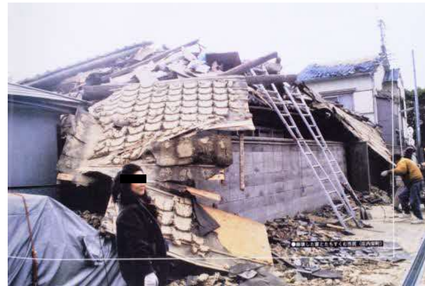
平成7年に発生した阪神・淡路大震災で被害を受けた家屋(庄内栄町)
