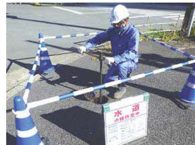
水道施設の点検のようす
