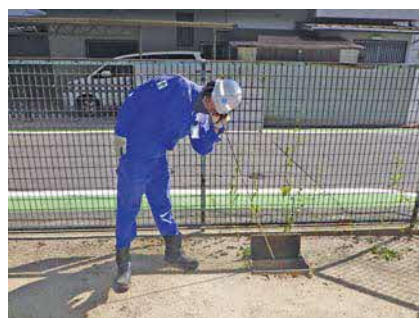
漏水防止活動のようす
