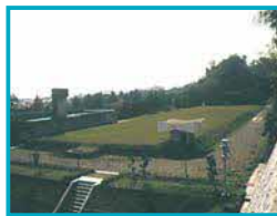
柿ノ木配水場
