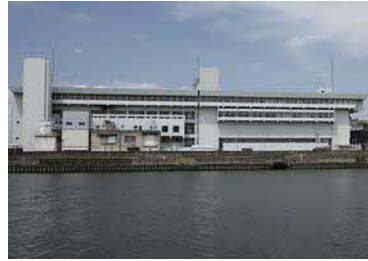
庄内下水処理場
