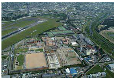
原田処理場の全景
