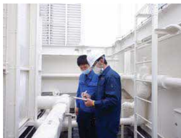
受水槽の管理状況調査の様子
