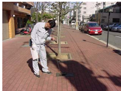
漏水防止活動のようす
