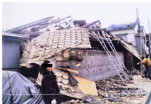
平成7年1月17日に発生した阪神淡路大震災で被害を受けた家屋(庄内栄町)
