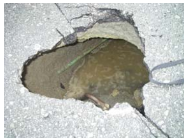
下水道管の老朽化が原因と考えられる道路の陥没
