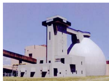
消化ガスを発生させる卵形消化タンク (原田処理場)
