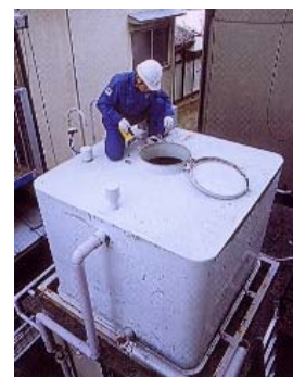
受水槽の管理状況調査
