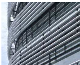
東・南東面の大型 水平ルーバー
