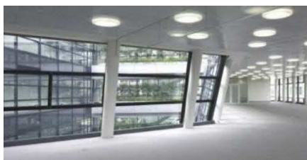
建物の中央に配置された吹抜け
