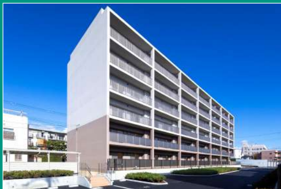
岡町北住宅 新棟 (宝山住宅)
