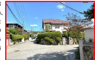
都市景観形成推進地区を定めた地区 (新千里西町3丁目地区)
