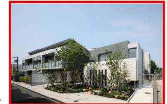
緑化スペースを十分配置したマンション 都市デザイン賞を受賞（豊南町西）
