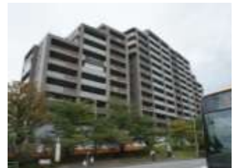
千里ニュータウンの住宅地区 (f) 中層から高層住宅の景観に大きく変化した。
