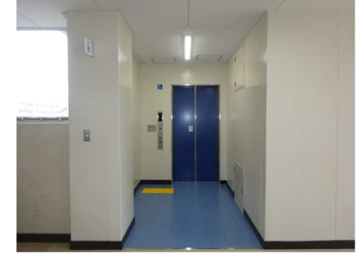
4階エレベーターホール
