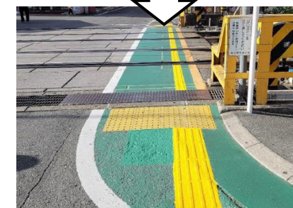
服部踏切(宝塚側)R6.12 整備
