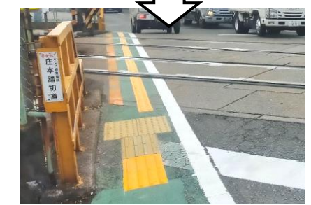
庄本踏切(大阪梅田側)R6.12 整備
