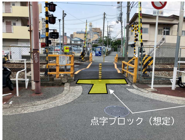
写真6：北ノ口踏切道（東側）
