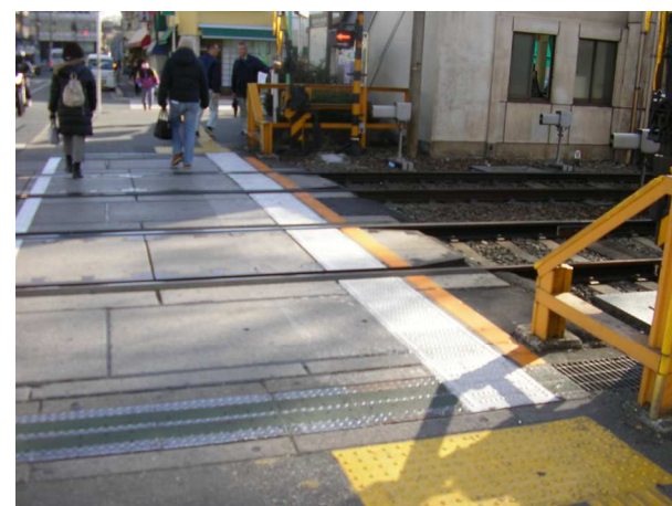
写真3：服部踏切道のエスコートゾーン
