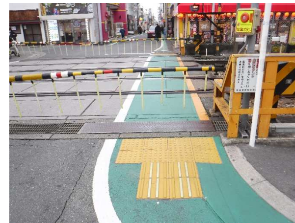
写真2：服部踏切道（府道）
