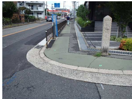
【歩道端部の縁石を改良し、点字ブロックを設置】
