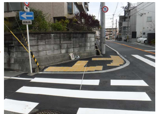
【交差点部の縁石、点字ブロックの改良】
