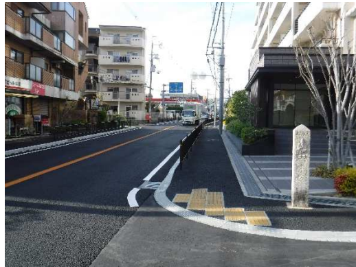
【歩道端部の縁石を改良し、点字ブロックを設置】
