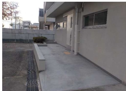
トイレ出入り口付近
