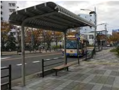
図 3.8 バス停ベンチ設置状況（旭ヶ丘北口バス停）
