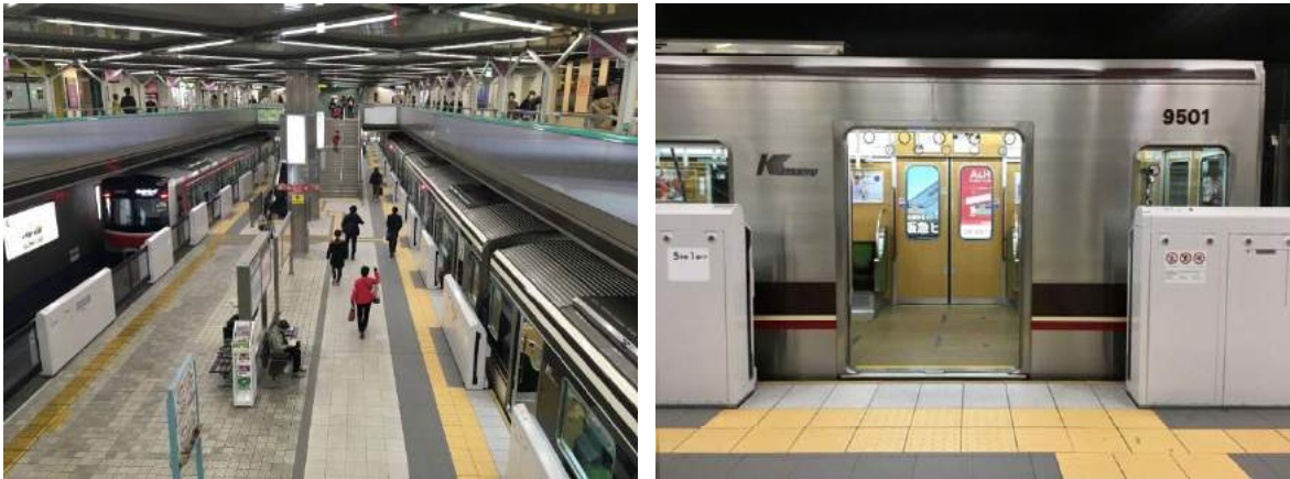
図 2.53 可動式ホーム柵設置状況（北大阪急行電鉄千里中央駅）
