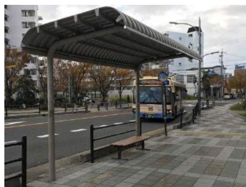
図 2.52 バス停ベンチ設置状況（旭ヶ丘北口バス停）
