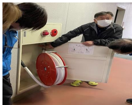
令和4年度 消火設備の使い方講習
