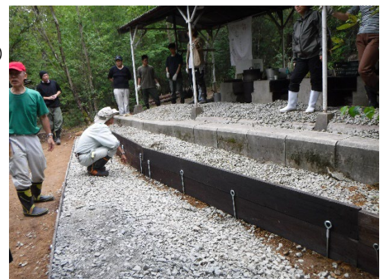
第1炊事場の段差解消で土留めと階段を設置。
