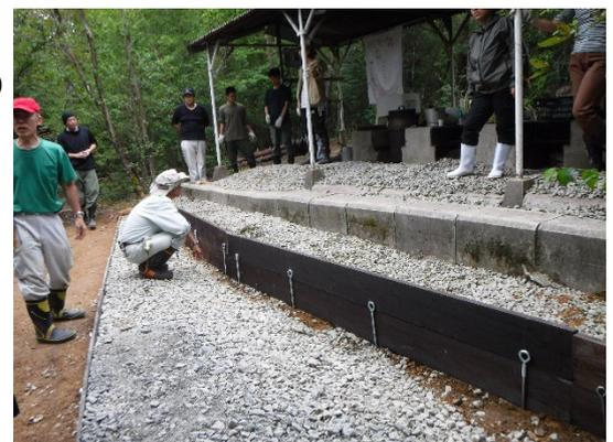
第1炊事場の段差解消で土留めと階段を設置。
