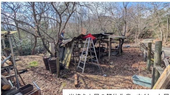
炭焼き小屋の解体作業。古くなった屋根や柱を撤去し、窯を掘り出した。
