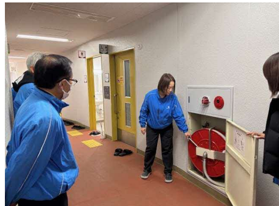
令和6年度 防災訓練の様子 (消火設備の説明確認) 豊中ローズ球場
