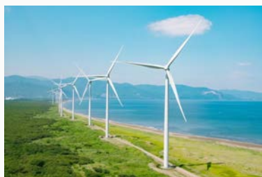
リエネ銭函風力発電所
