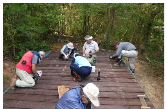
テントベースのウッドデッキ化
