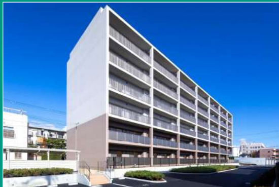
岡町北住宅 新棟 (宝山住宅)
