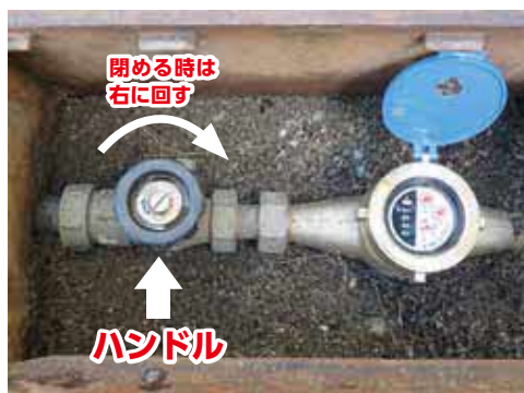
ハンドルを回すタイプの止水栓。レバー式もあります
