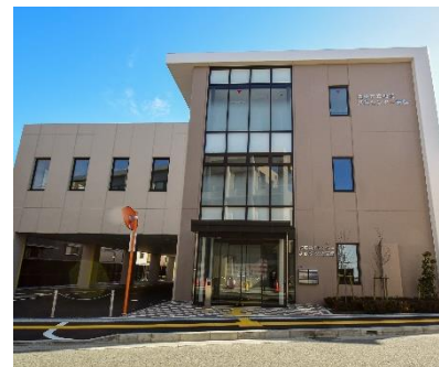
地域共生センター東館外観
