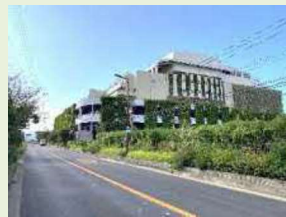
壁面緑化と敷地緑化でうらおい豊かな焼却施設（原田西町）
