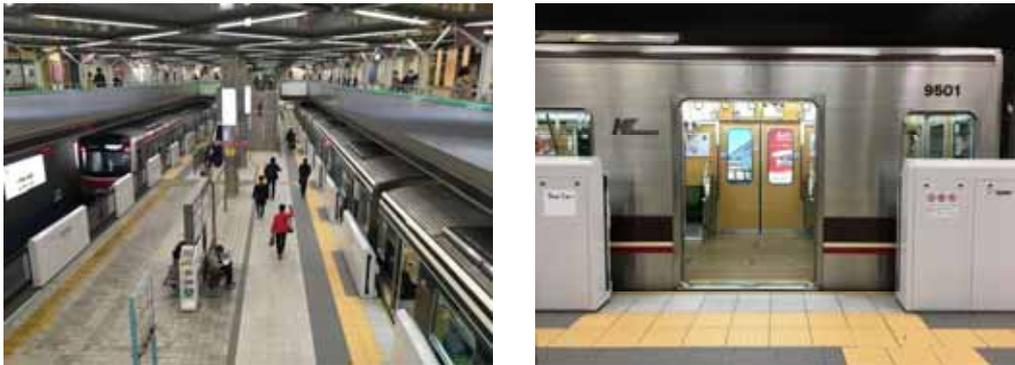
図 3.7 可動式ホーム柵設置状況（北大阪急行電鉄千里中央駅）
