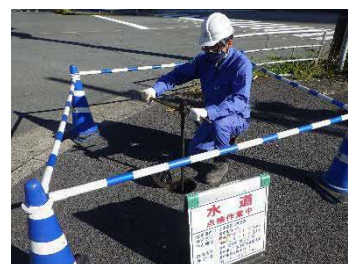
水道施設の点検のようす
