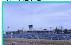
柿ノ木配水場
