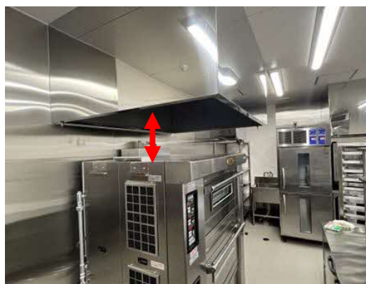
写真2 デッキオーブンとグリス除去装置との距離
