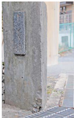
右奥のネットフェンスの向こう側にも親柱があります
