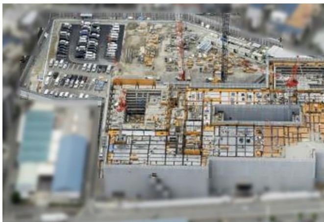
庄内よつば学園 建築の進捗状況(6/25撮影)
