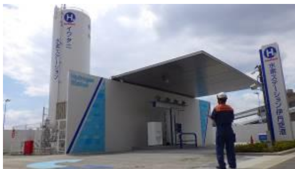
高圧ガス施設の査察
