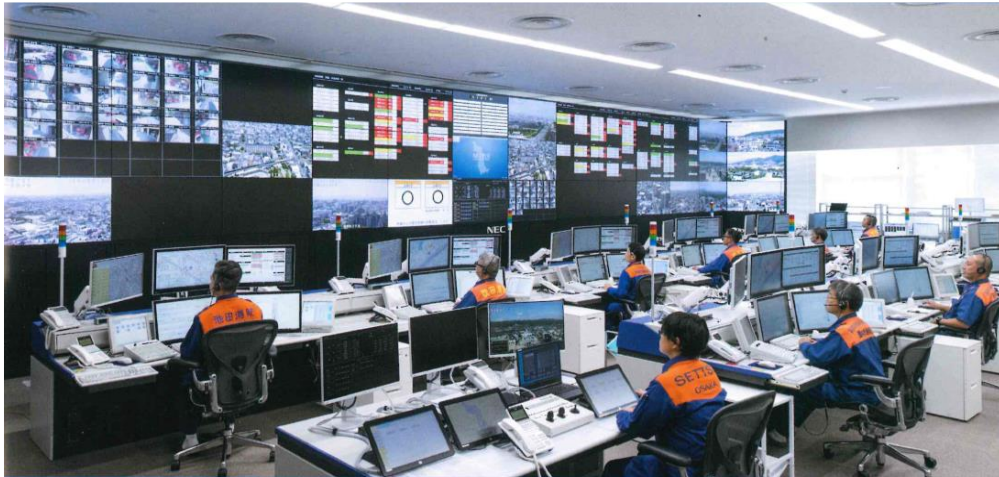
北大阪消防指令センター指令室
