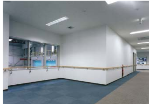
図 4-3 プラットホームを見下ろせる事例 (1)
