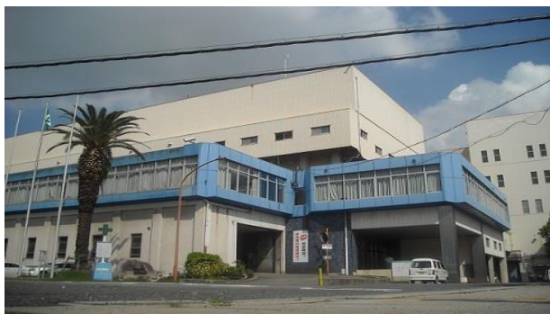
＜旧ごみ焼却施設＞
