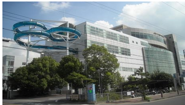
＜余熱利用施設＞
