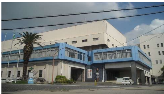
＜旧ごみ焼却施設＞
