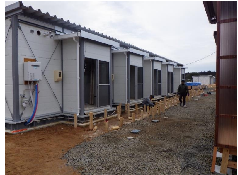
仮設住宅建設現場の確認
