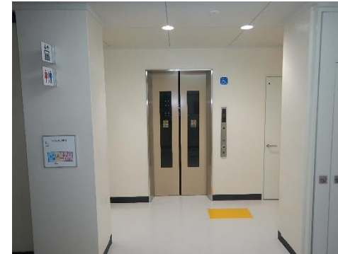
1階エレベーターホール
