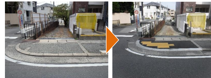
曾根箕面線 段差解消、点字ブロック敷設
