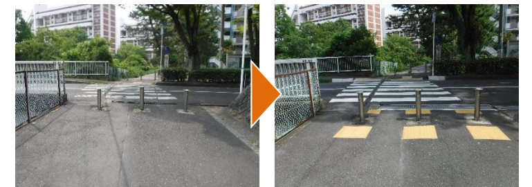
北緑丘団地線 グレーチング蓋の改修、点字ブロック敷設
