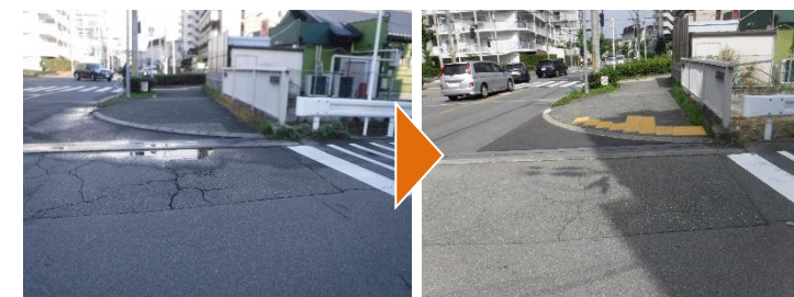
千里園熊野田線 段差解消、点字ブロック敷設
