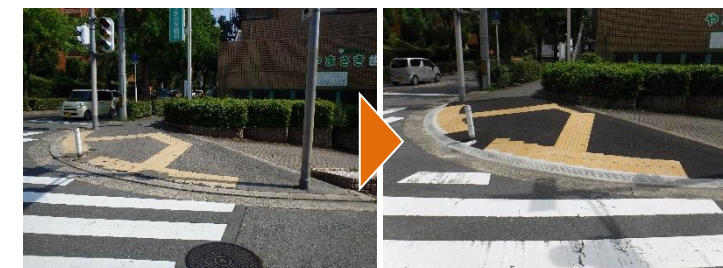
翠丘東豊中線 段差解消、点字ブロック敷設
