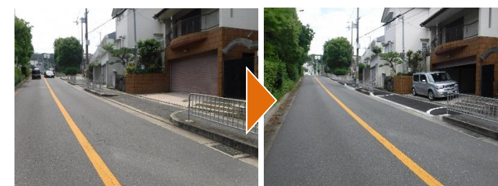
緑丘北通り線 車両乗入部の段差解消、勾配緩和
