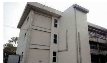
小中学校のエレベーター設置
