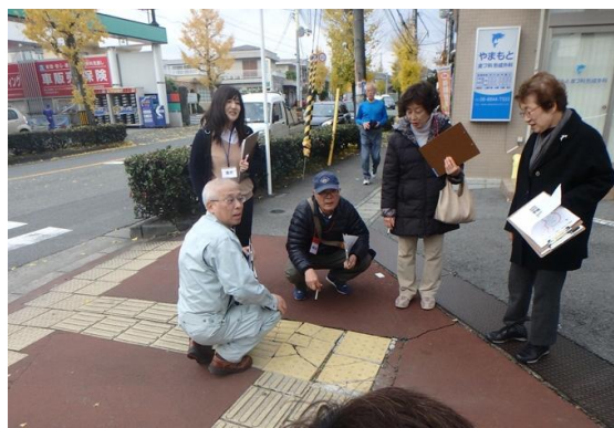
現地点検の様子
