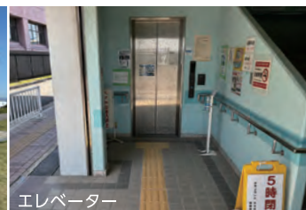
エレベーター
