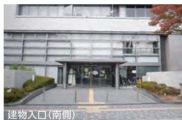
建物入口(南側)
