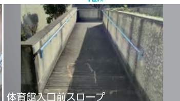
体育館入口前スロープ
