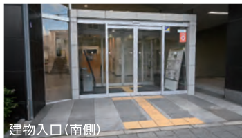
建物入口(南側)
