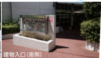
建物入口(南側)
