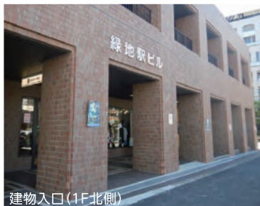
建物入口 (1F北側)
