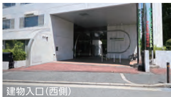
建物入口(西側)
