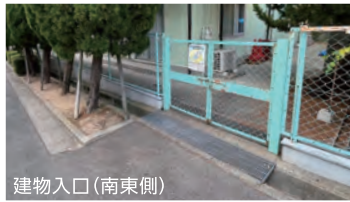
建物入口(南東側)
