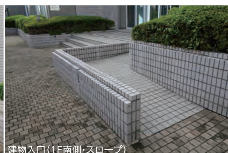
建物入口 (1F南側・スロープ)
