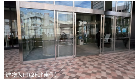
建物入口(2F北東側)
