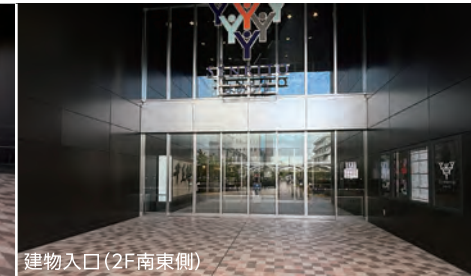
建物入口(2F南東側)
