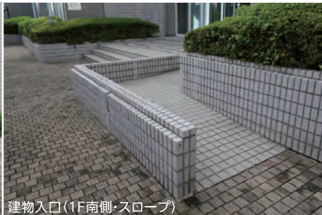
建物入口 (1F南側・スロープ)
