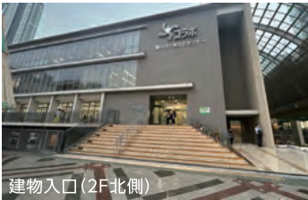
建物入口(2F北側)
