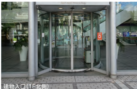
建物入口 (1F北側)
