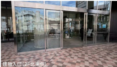
建物入口(2F北東側)
