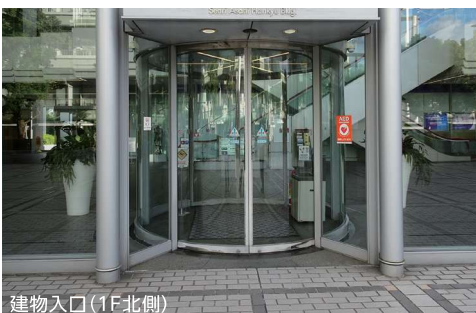
建物入口 (1F北側)
