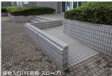
建物入口 (1F南側・スロープ)
