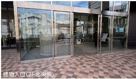
建物入口(2F北東側)
