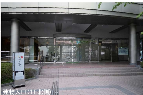
建物入口 (1F北側)
