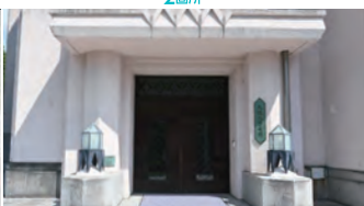
建物入口(メイン)
